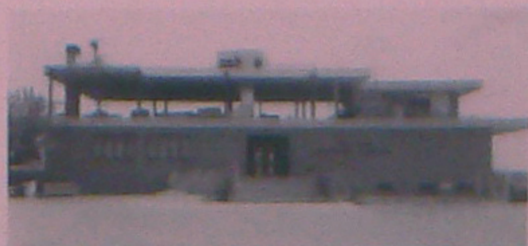
Construcció el 1986 de la segona planta de l'Aero Club. Foto: Pere Farran - Diari de Sabadell
